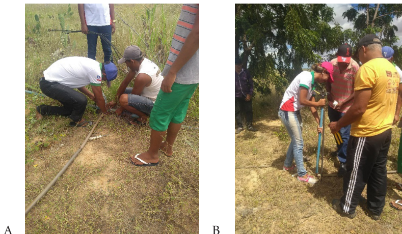
Figura 3 – (a) Instalação do tubo de PCV a linha de derivação; (b) Instalação de aspersor na área de irrigação
