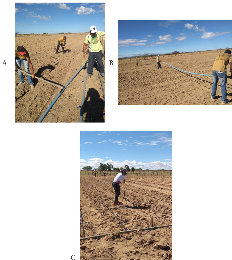
Figura 5 – (a) Abertura de vala e instalação da linha de derivação na área irrigada; (b) centralização da linha principal na área irrigada; (c) instalação da linha principal a linha de derivação
