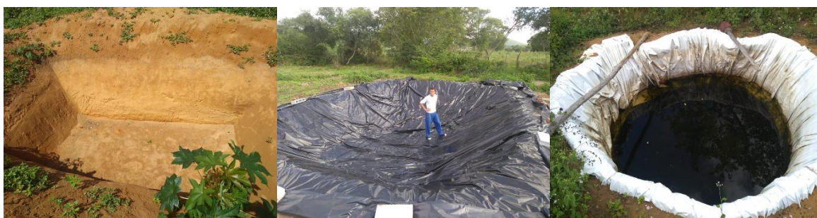
Figura 9. Construção de tanques de armazenamento e captação de água de chuva
