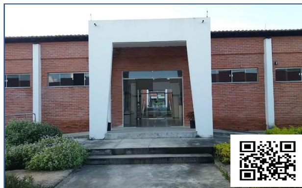
Novo pavilhão administrativo
