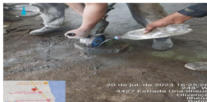
Figura 18- Imagens de corte dos pisos para composição da bancada.
