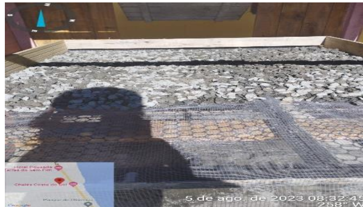
Figura 26 – Ilustração das camadas de brita e areia utilizadas na montagem do sistema de drenagem.
