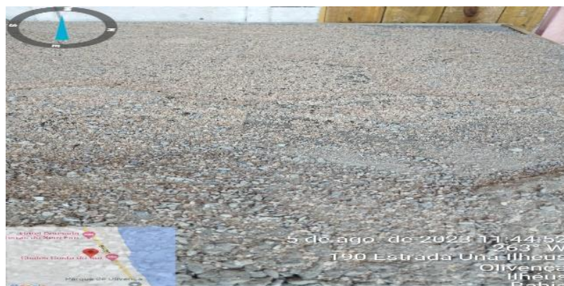
Figura 28- Rejuntamento dos pisos com areia.
