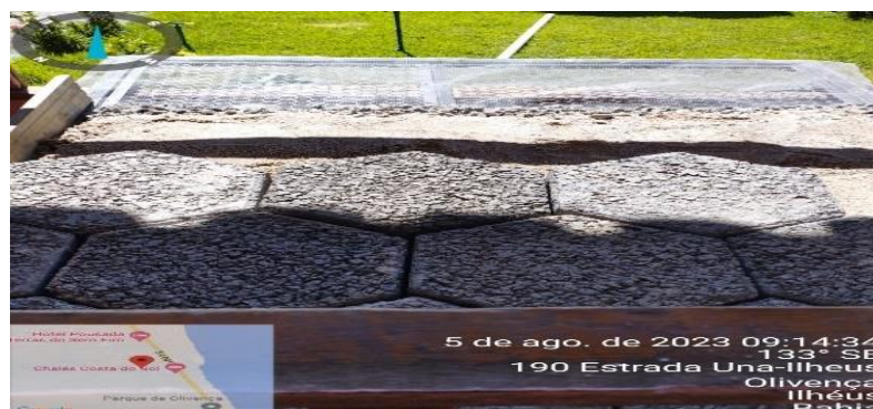
Figura 27: Execução de piso na bancada.
