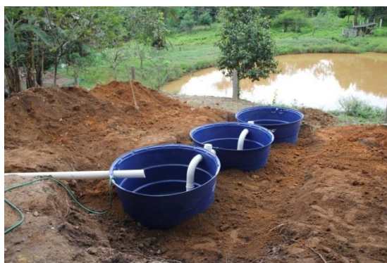
Figura 5: Montagem da fossa biodigestora no solo.
