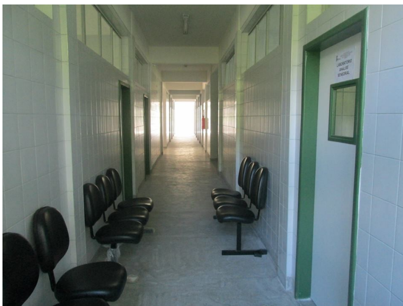
Figura 4 - Pavilhão Laboratórios Analíticos, Salas de Aulas e Gabinetes de Servidores
