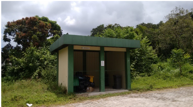
Figura 24 - Depósito de Resíduos Sólidos
