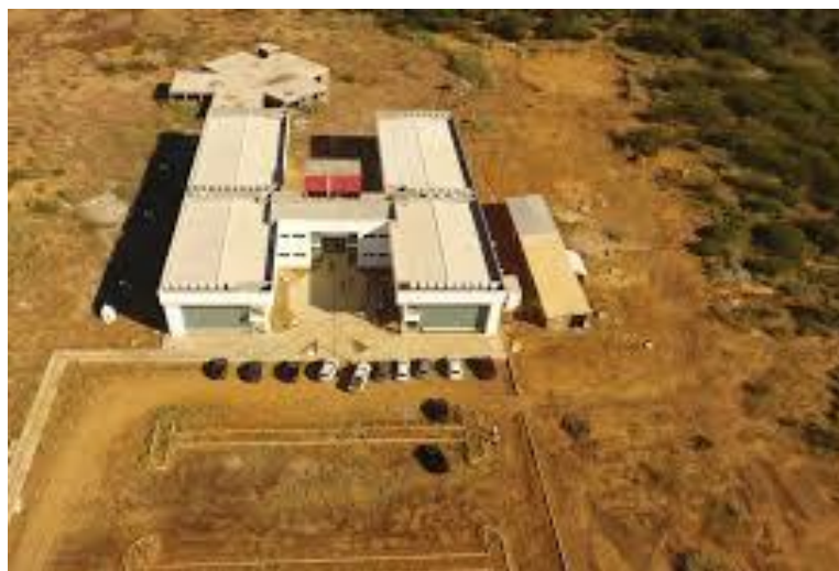
Figura 4. Módulo de salas de aula do Instituto Federal Baiano de Educação, Ciência e Tecnologia Baiano – campus Xique-Xique.
